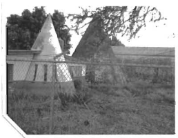
Imagen III.9.- Instalaciones de bodegas de conasupo, Jomulco.
